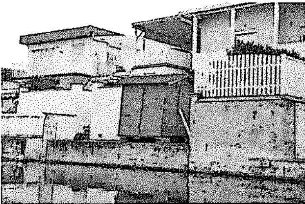
Fotos 1 bis 4: Uferbefestigungen mittels Mauern
